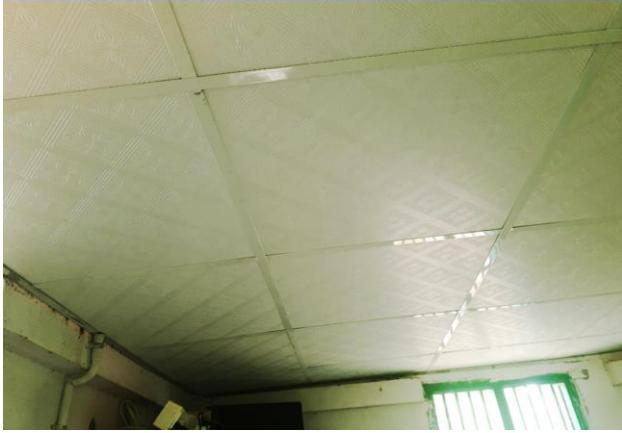
Le bureau a été couvert de plaques de plâtre thermofiltrées, en remplacement des plaques cimentées.
